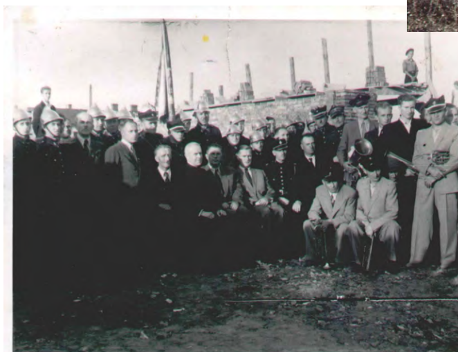
Budowa remizy OSP Mszczonów
